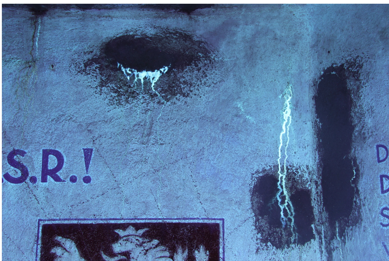
Obr. 42: Část jihovýchodní stěny. Fotografie v UV světle. Na snímku pozorujeme silnou luminiscenci až fluorescenci na místech, kde se projevuje krasový jev.
