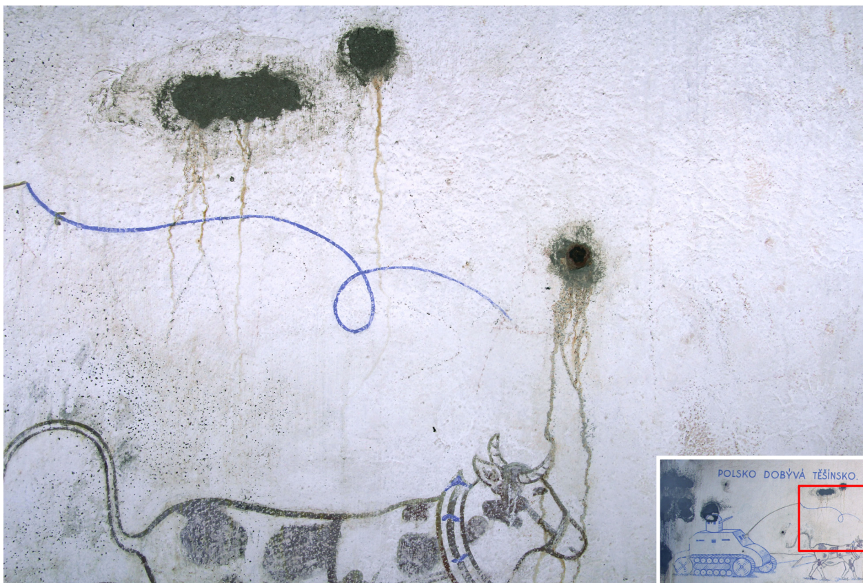
Obr. 29: Detail části malby na severovýchodní stěně, nad kterou je vidět stopy po degradaci dnes zatmelené železné armatury. Podle historických fotografií je zřejmé, že od roku 1997 nedošlo v tomto místě k výraznému nárůstu počtu stékanců. Důvodem může být tehdejší konzervační zá- krok či snížení kondenzace vzdušné vlhkosti v objektu.
