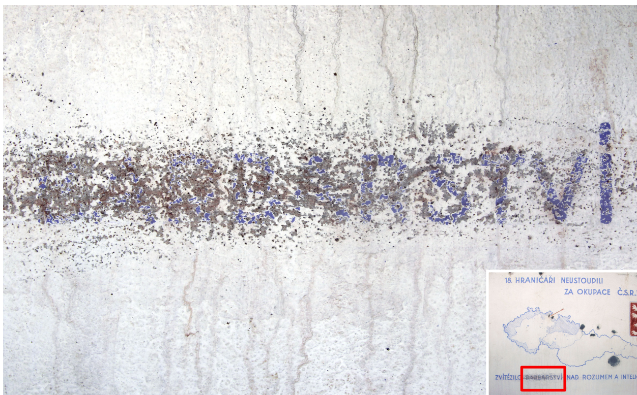
Obr. 19: Detail části malby na jihovýchodní stěně. V tomto místě jsou přítomny ztráty barevné vrstvy v nápisu „BARBARSTVÍ“ do takové míry, že způsobují jeho špatnou čitelnost. Poškození bylo zapříčiněno vandalským činem.
