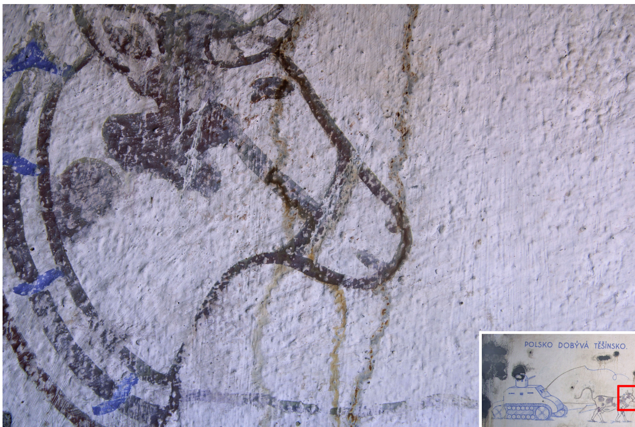
Obr. 30: Detail části malby na severovýchodní stěně. V tomto místě je malba poškozena stékanci zapříčiněnými degradací dnes zatmelené železné armatury.
